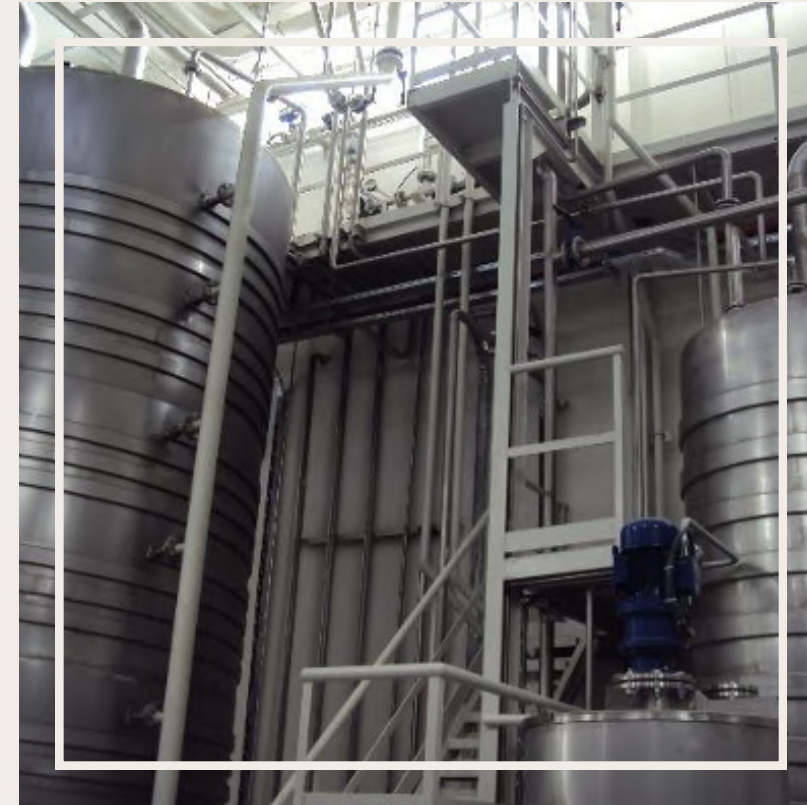
ALKOL FABRİKASI PASLANMAZ SERPANTİNLİ TANK İMALATLARI
