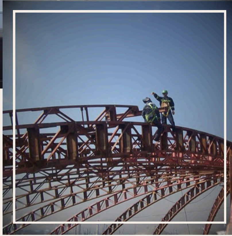
TANK ÇATI MAKASI İMALATI MONTAJI
