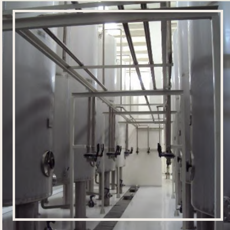
ALKOL FABRİKASI PASLANMAZ TANK MONTAJI
